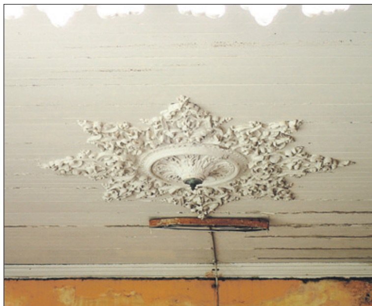
Detail op plafond.
